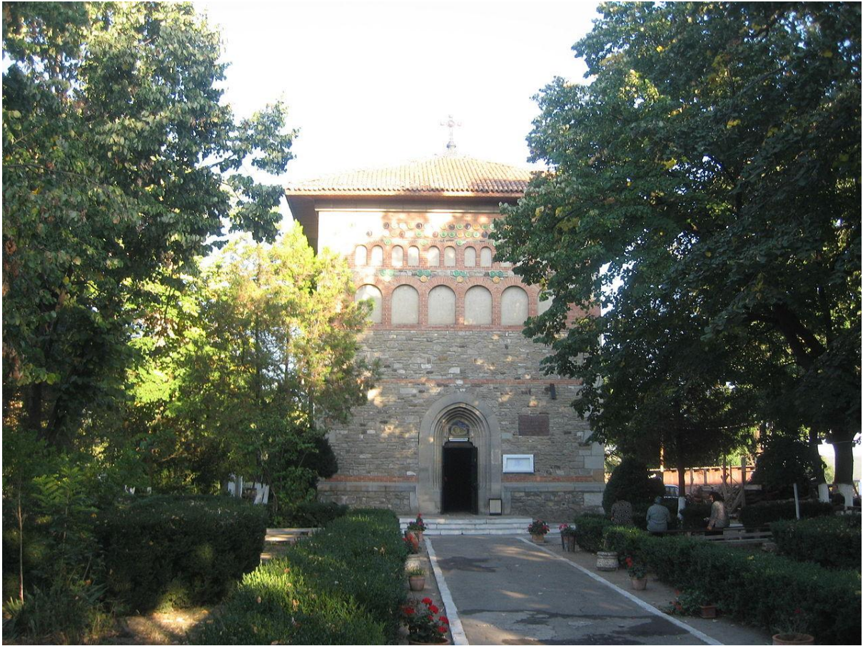
Biserica "Sf. Ioan" din Vaslui - vedere dinspre vest
